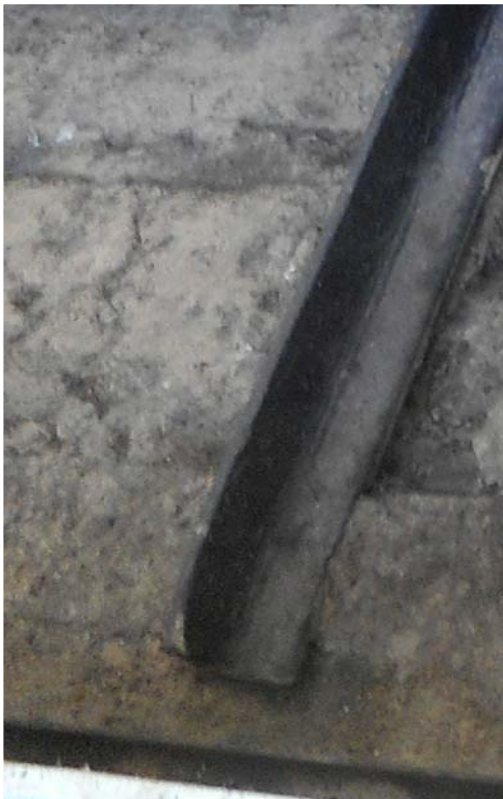
CUADRANTE 3. Deformaciones generalizadas de las placas, en el encuentro con la cornisa
